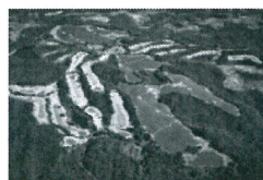
出力約37MWの「新岡山太陽光発電所」
